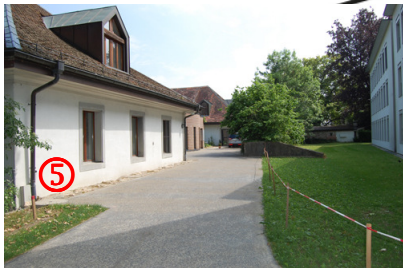
Folgen Sie dem Kiesweg bis zum hinten liegenden Backsteingebäude.
